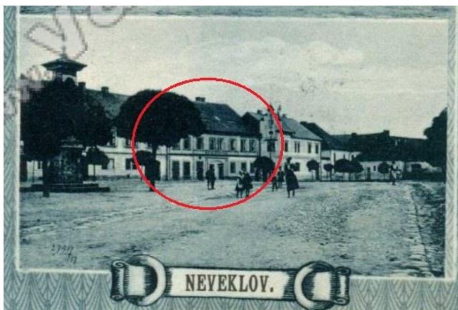
Obr. č. 35 – Dům rodiny Roubíčkovy – dříve 91
