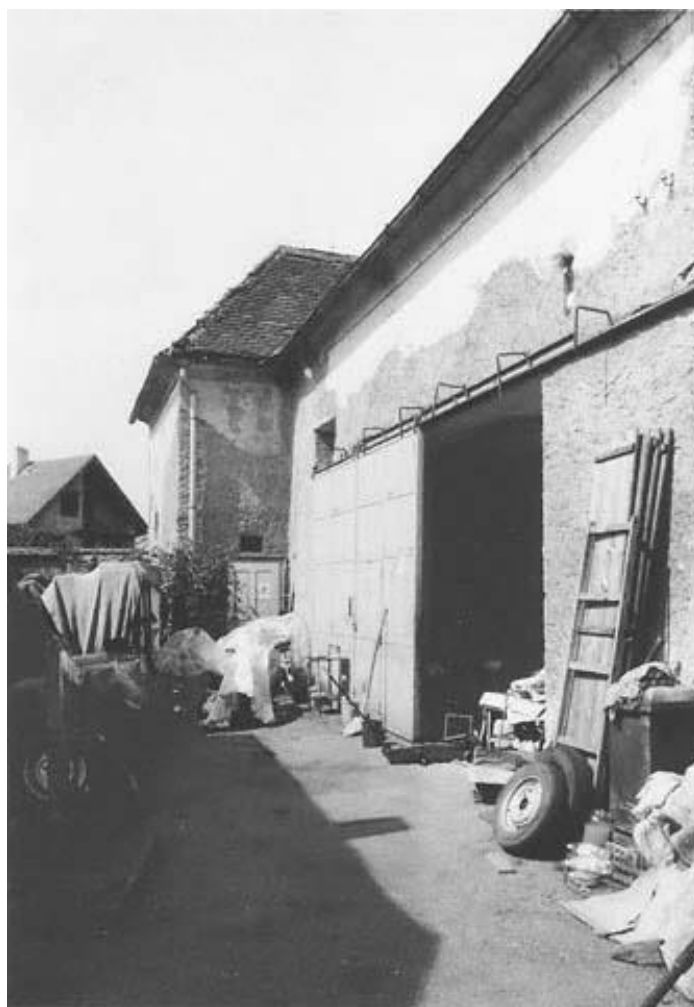
Obr. č. 12 – Synagoga – přestavba na zemědělský sklad – dříve 73
