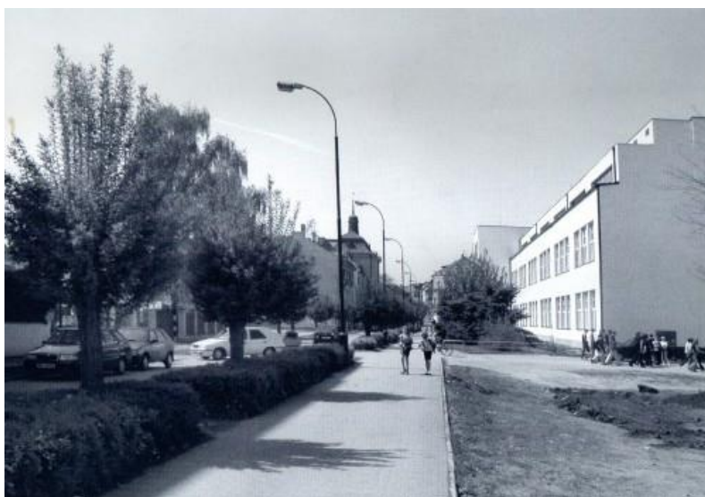
Obr. č. 9 Výstavba ZŠ Jiráskova
