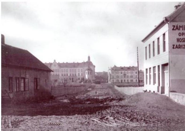
Obr. č. 8 Výstavba ZŠ Jiráskova
