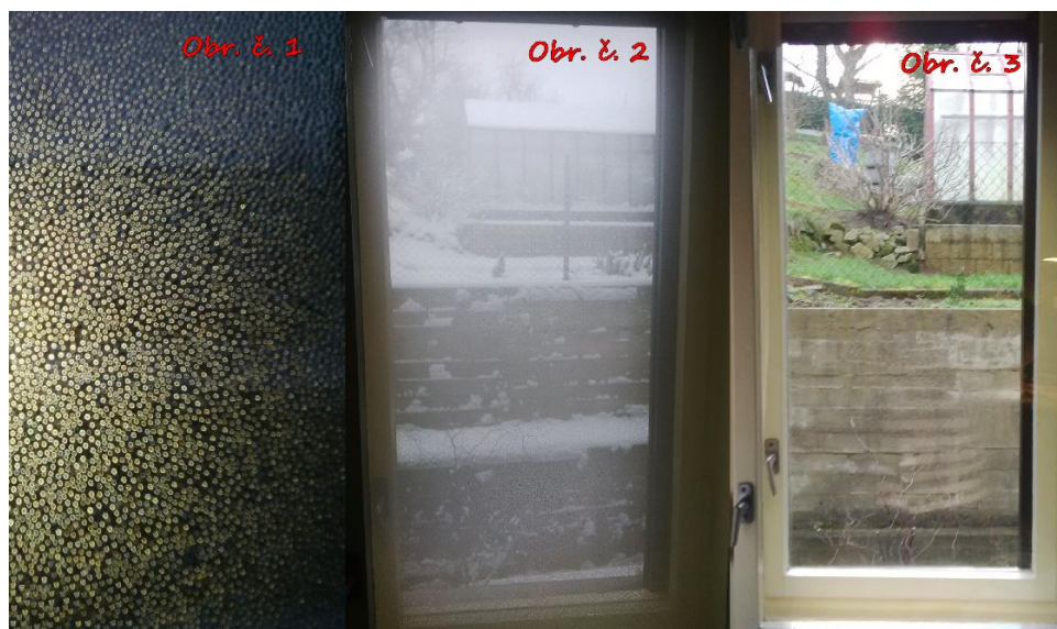
Obr. 4: Okno – před, v průběhu a po instalaci (Zdroj: Vlastní materiál)
