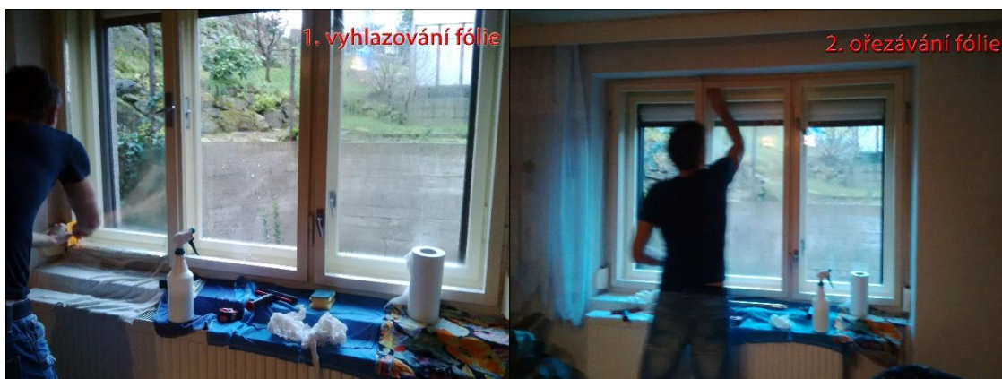
Obr. 3: Instalace fólií v pokoji č. 1 (Zdroj: Vlastní materiál)
